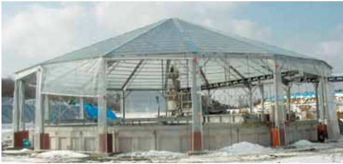
全方位原料投入の発酵槽全景
