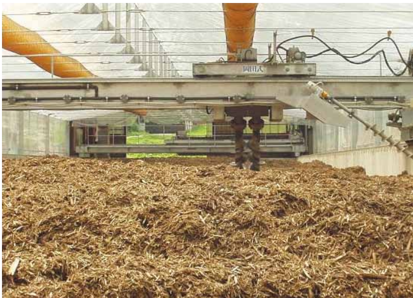
稼働中のスクリー攪拌機
