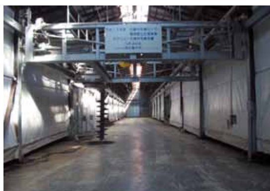
攪拌堆積発酵槽の密閉カーテン施設
